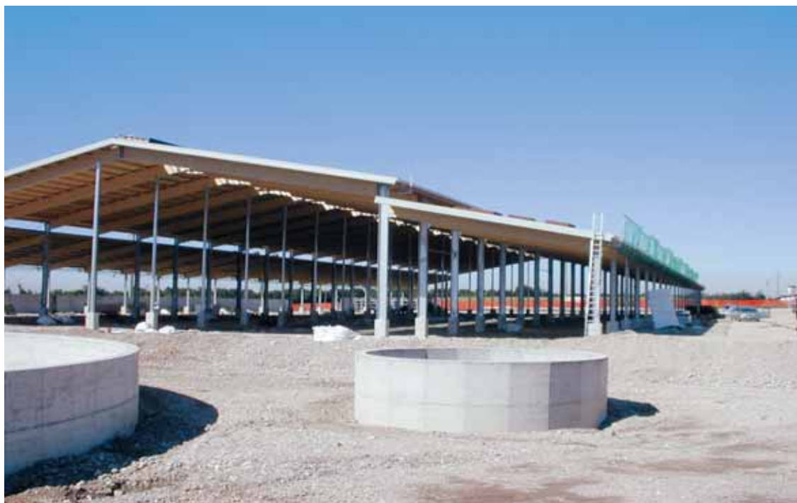
Esempio di ricovero zootecnico in fase di costruzione. (Foto Wolf System)
