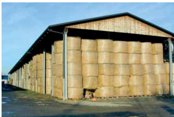
Capannone rurale adibito a deposito alimento/lettime.
