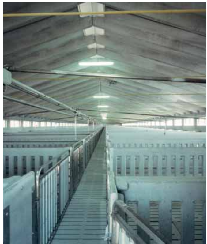
Porcilaia con box a pavimento fessurato.
