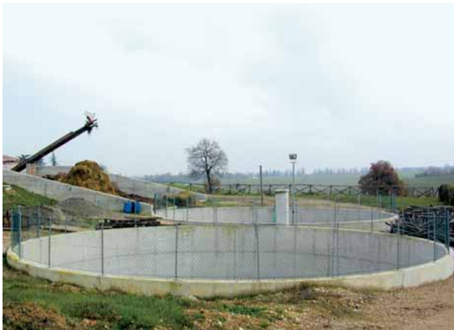
Vasche interrato di calcestruzzo armato.
