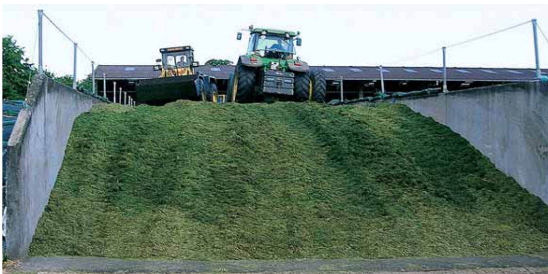
Barriere anticaduta installate alla sommità dei muri di contenimento di un silo orizzontale fuori terra.
