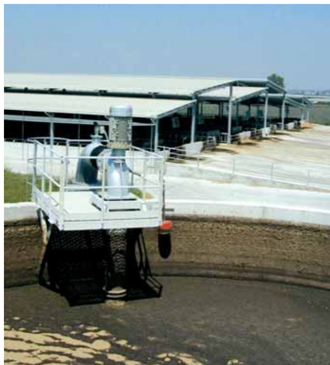
Vasca per effluenti non palabili.
