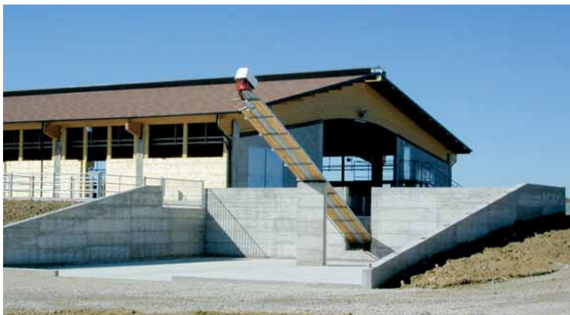
Concimaia a platea con pareti di contenimento su 3 lati.
