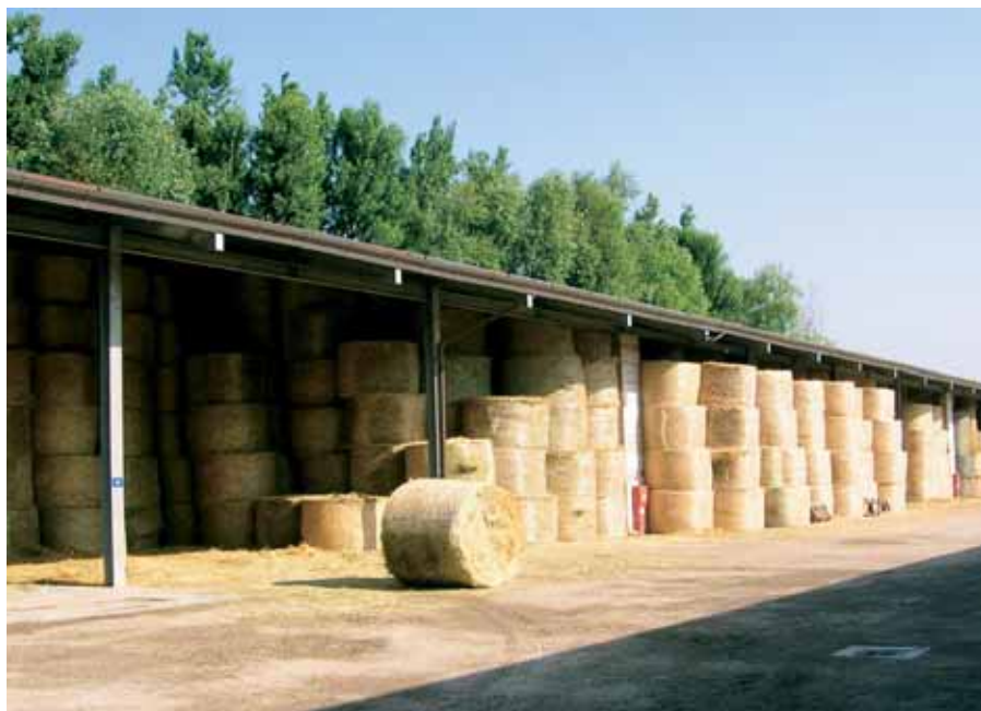
Esempio di capannone per lo stoccaggio di paglia e fieno.
