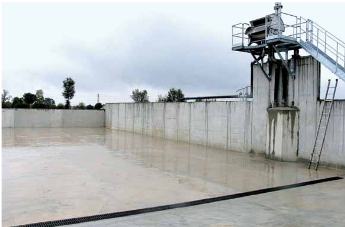
Concimaia a platea con pareti perimetrali e separatore per liquame.
