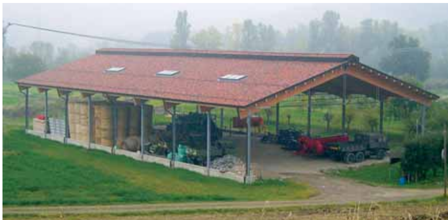
Struttura portante mista acciaio-legno.
