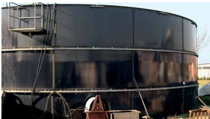
Vasca circolare in piastre d'acciaio smaltate.
