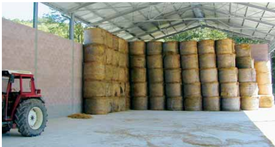
Fienile con struttura portante d'acciaio, tamponamenti di calcestruzzo alleggerito e copertura con pannelli sandwich.
