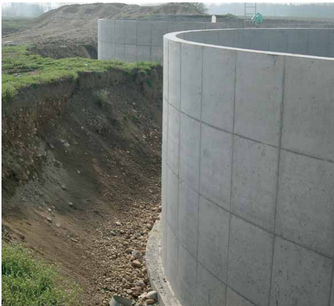
Vasche cilindriche seminterrate di calcestruzzo in fase di costruzione.
