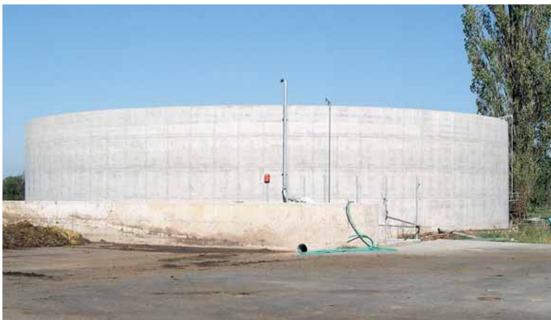
Vasca cilindrica di calcestruzzo fuori terra.
