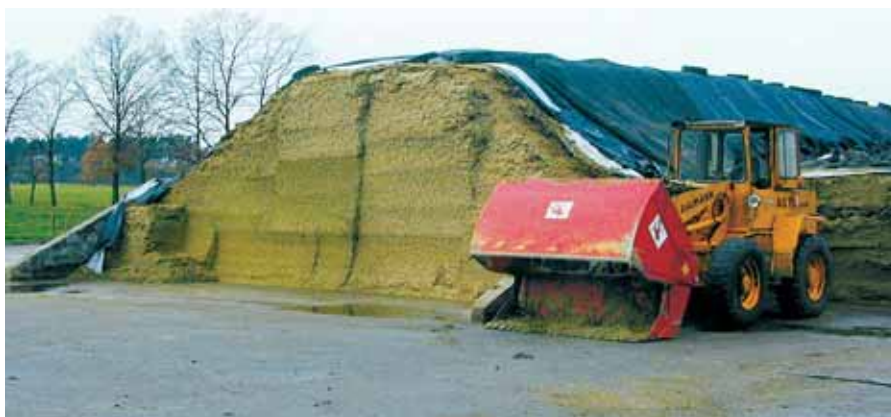
Silo a trincea con pareti di contenimento.
