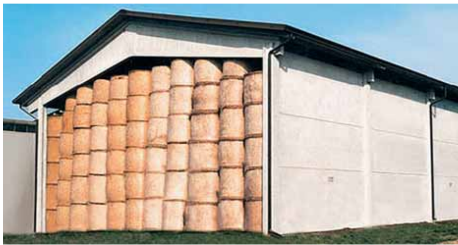
Fienile con struttura portante di calcestruzzo armato.
