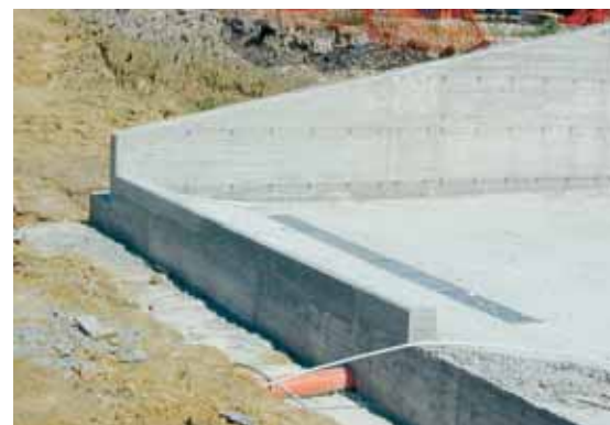
Canale grigliato per l'allontanamento della frazione liquida del letame e dell'acqua piovana raccolta dalla platea.
