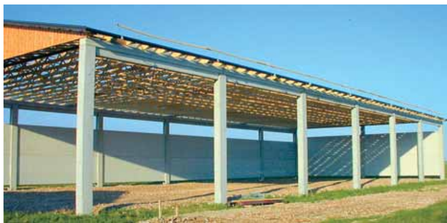
Fienile con struttura portante mista calcestruzzo-legno. (Fonte: Wolf System)
