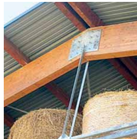
Fienile con travi di legno e copertura di lamierino d'acciaio grecato.
