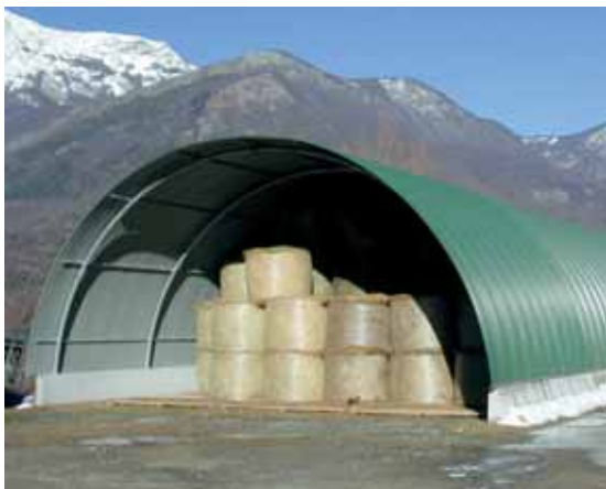
Fienile con struttura tubolare d'acciaio e copertura rigida.
